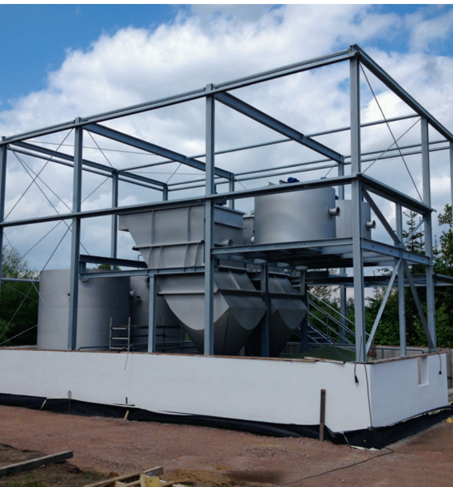
Abb. 5: Anlage zur kontinuierlichen Schlammwasseraufbereitung im Rohbau
