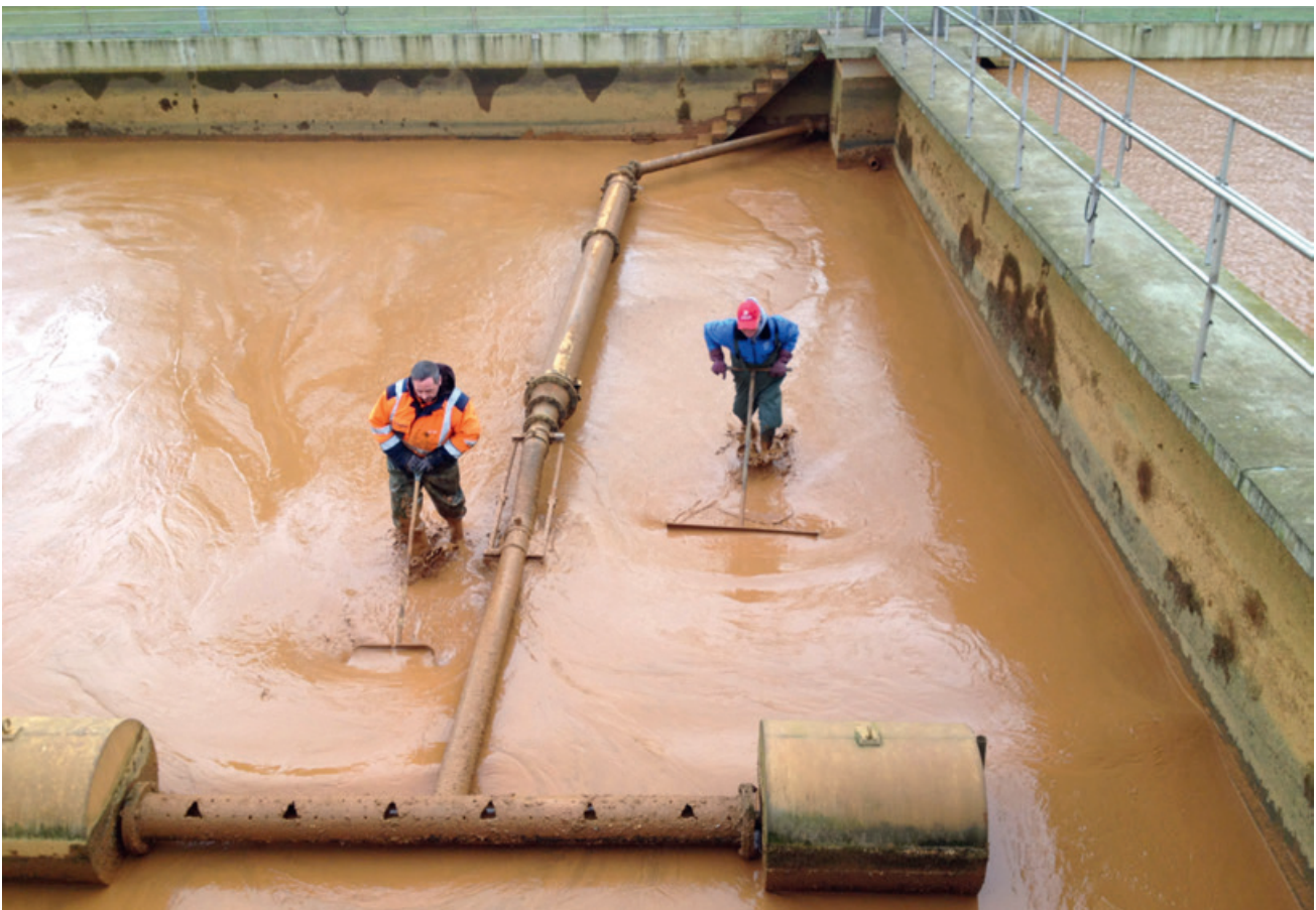
Abb. 1: Beckenräumung im Rahmen der Sanierung
